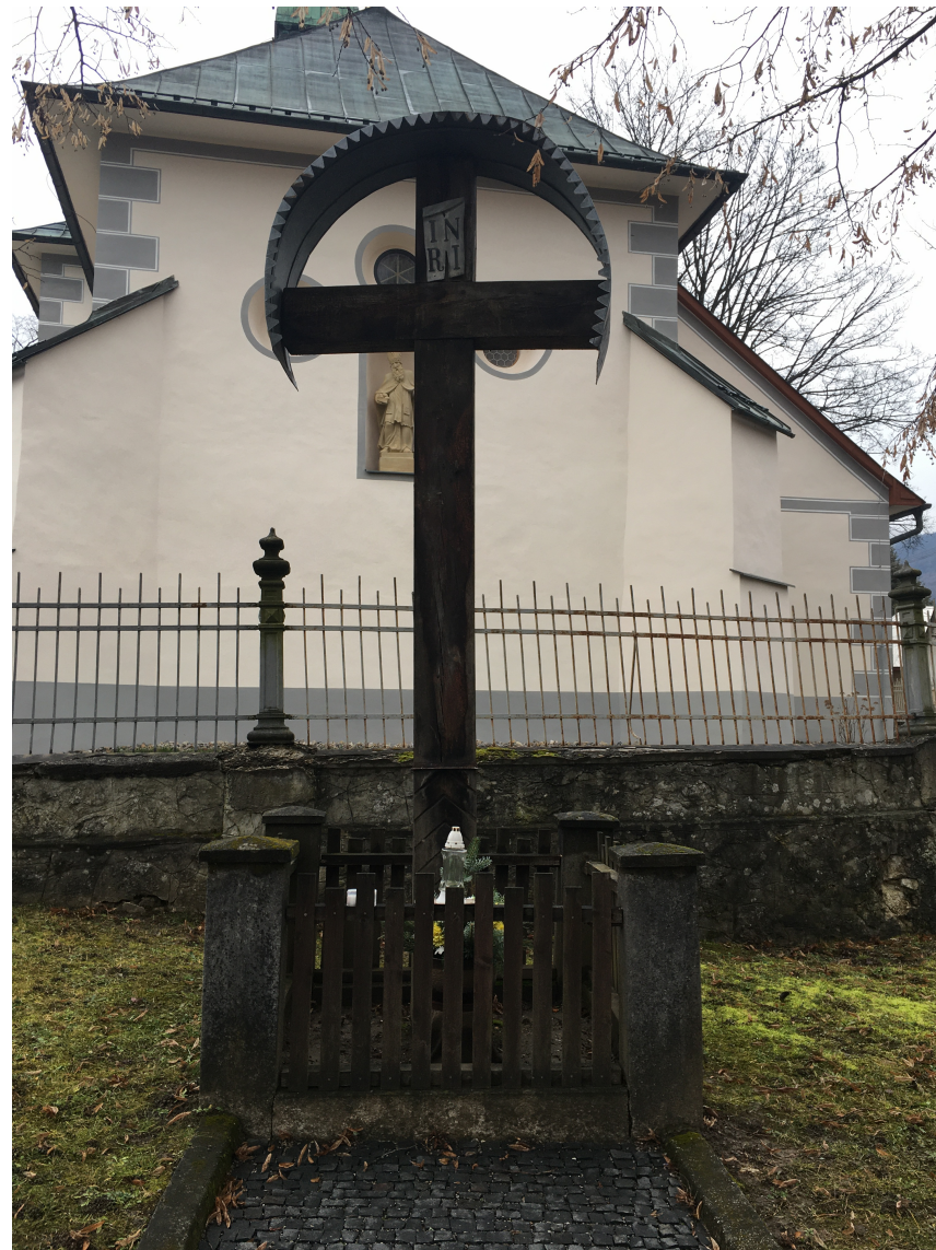
stav po demontáži
